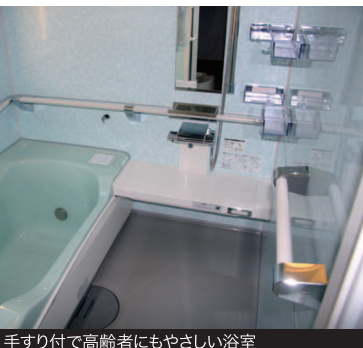
手すり付で高齢者にもやさしい浴室
